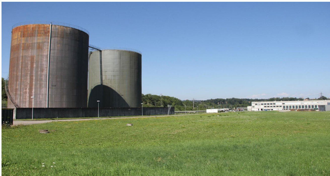
Les cuves du MIC avant leur destruction – Photo © Luc Monteleone – juillet 2018
