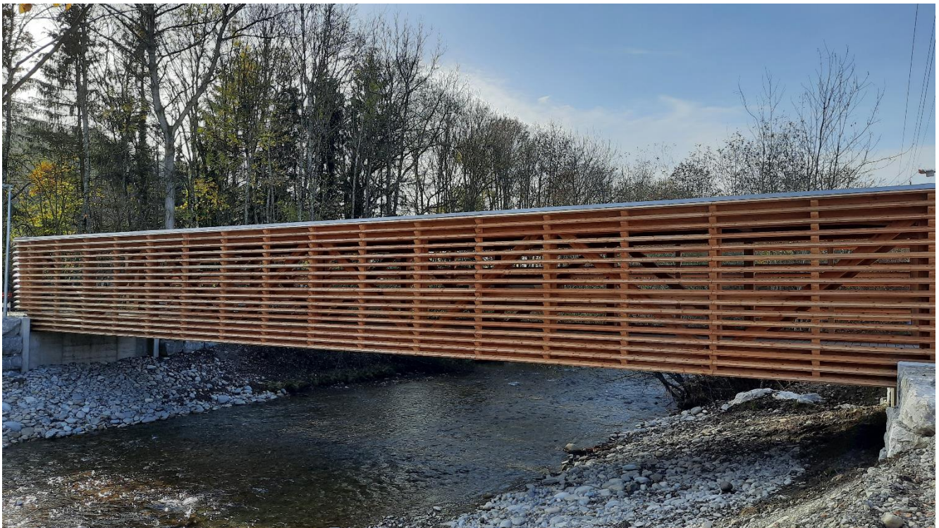
Nouvelle passerelle sur la Gérine – Photo © Jean-Pierre Helbling – octobre 2020
