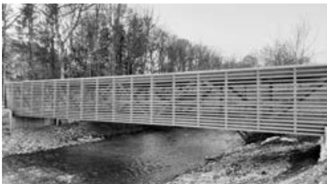
Nouvelle passerelle sur la Gérine
