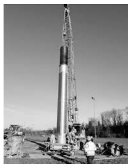
Mise en place de la crépine
