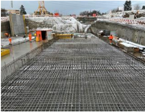
Ferrailage de l'abri PC
