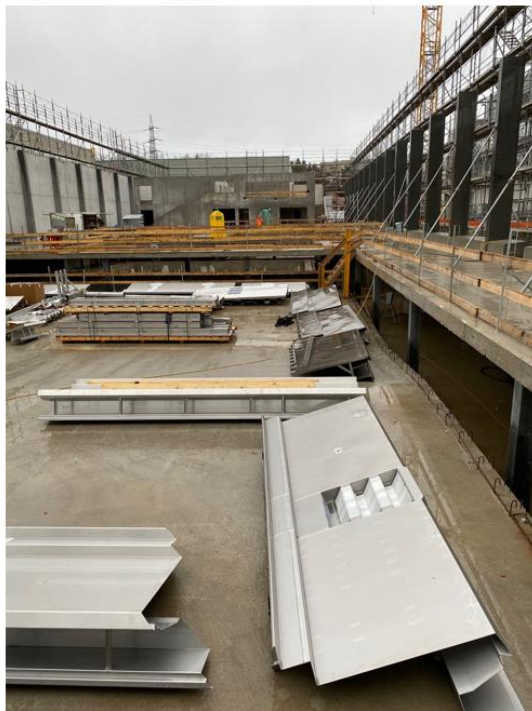
1 er décembre 2021 – Pose des bassins
