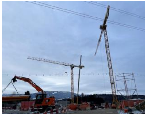
Montage de la 2 ème grue
