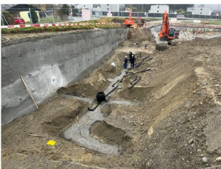
Pose des canalisations
