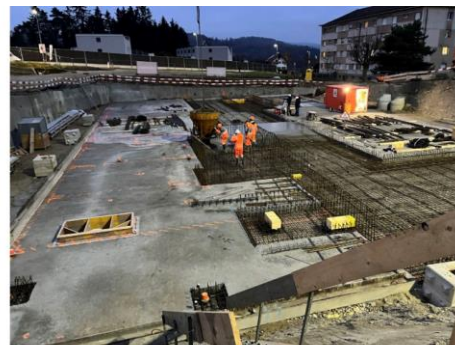
Bétonnage radier
