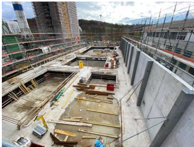
9 novembre 2021 – Vue des bassins
