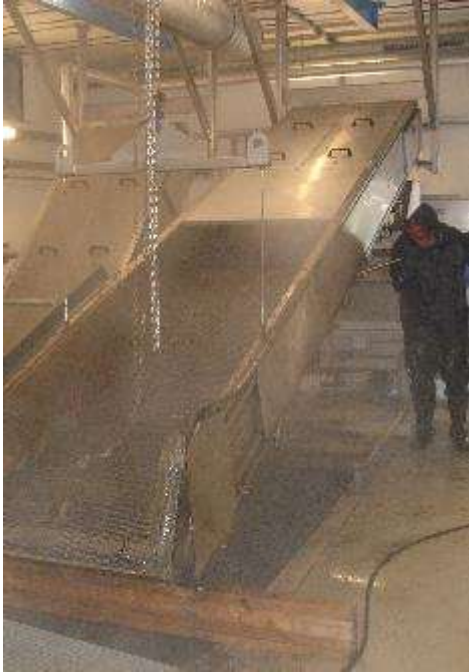
Nettoyage du dégrillage
