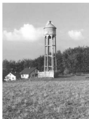
Le château d'eau construit en 1926...
